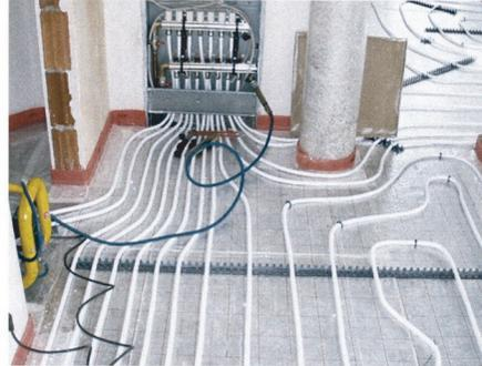
Bild 01: Anschluss der Fußbodenheizung an den Verteiler im EG, Wohnzimmer vor Tür zum Schlafzimmer
