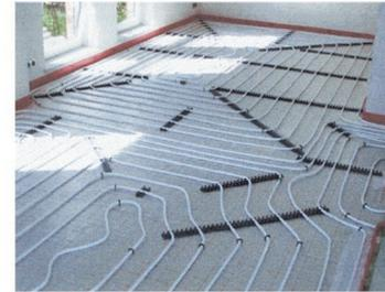
Bild 06: Fußbodenheizung im EG, Wohnzimmer Ecke Giebel/Hofseite
